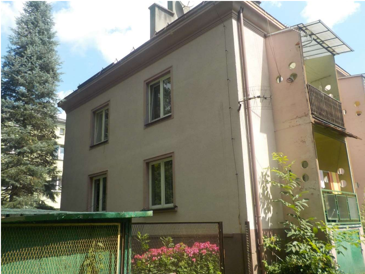
Widok na elewację zachodnią
