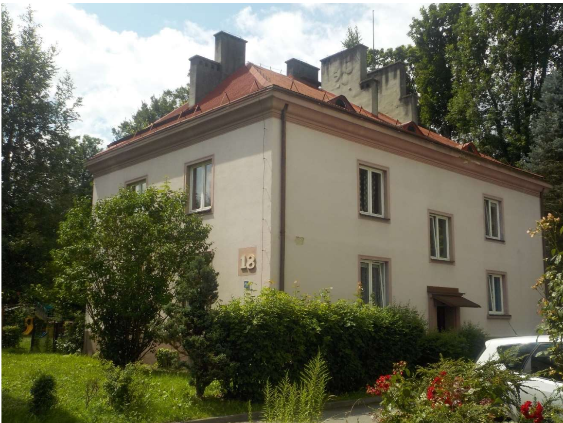
Widok na elewację wschodnią i północną
